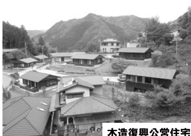
木造復興公営住宅
