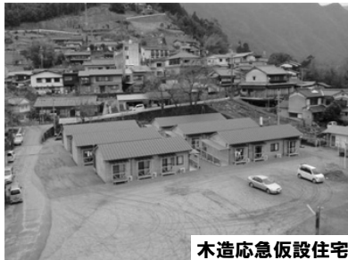
木造応急仮設住宅
