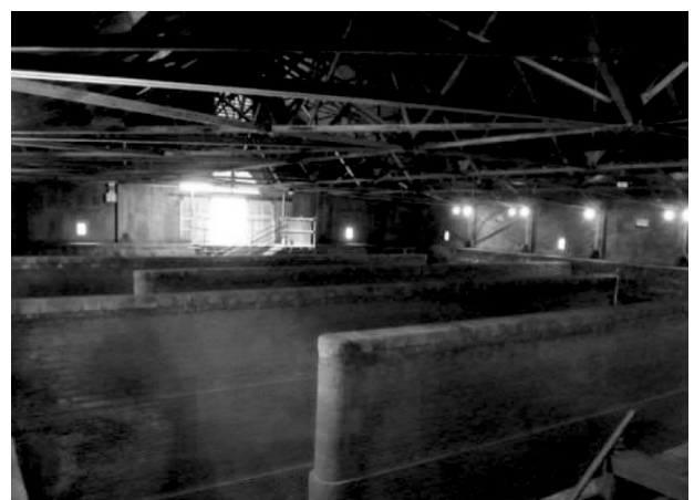
写真2 北吸配水池の内部写真
