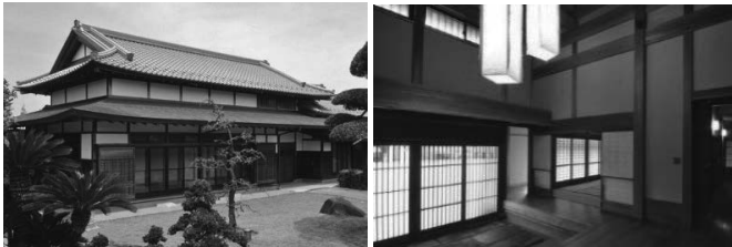
土塗壁の例（左：外部、右：内部）
