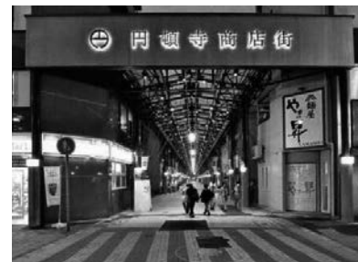
アーケードの改修、空き店舗の再生
