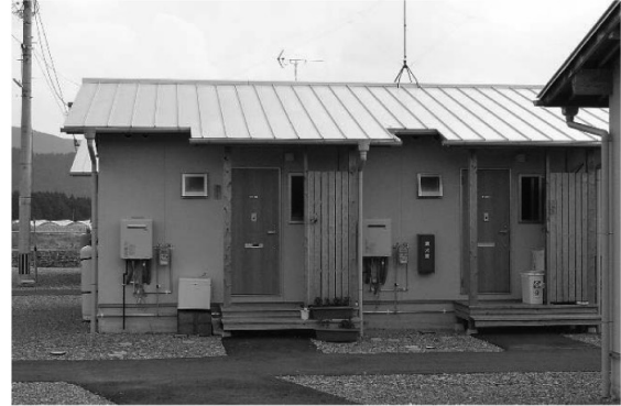
木造仮設住宅
