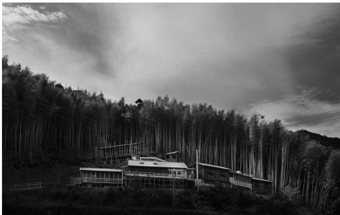
「普段づかい」から始まる先行高地移転の事例 津波到達水位よりも上で形成される新しい集落「こうのすまい」
