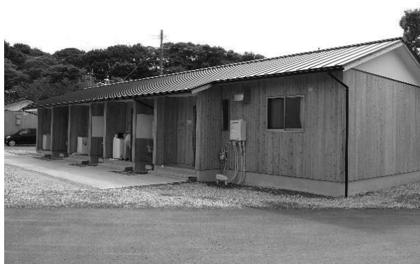
建築士会の木造仮設住宅
