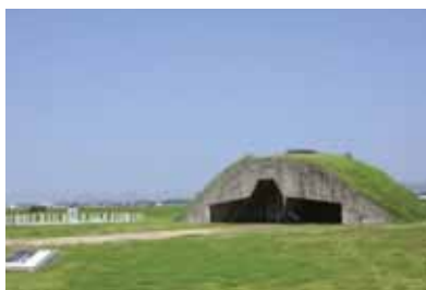
写真2 城井一号掩体壕
