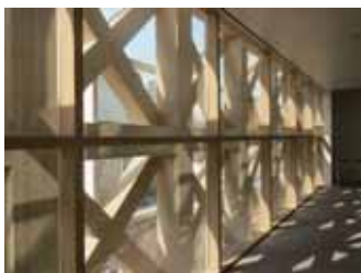
壁面の木造トラス
