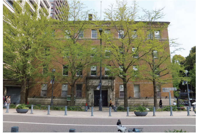
写真2 日本綿花横浜支店 (渡辺節、1928年)
