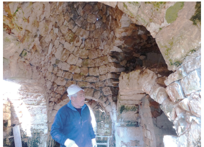
写真4 修復中のトウルツリ内部で働くトウルツラーロ(職人)
