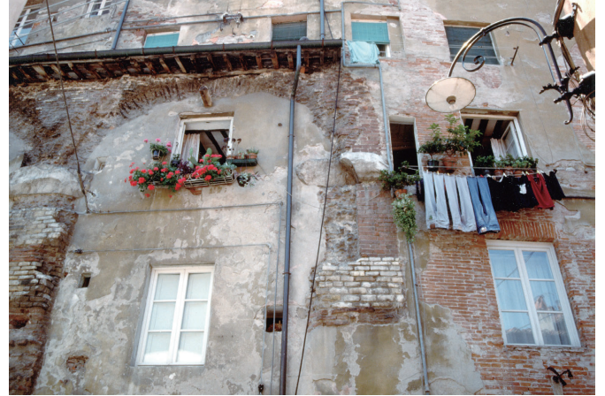
写真7 円形闘技場街区の外壁
