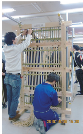
図4 下地竹(縦)の取付け
