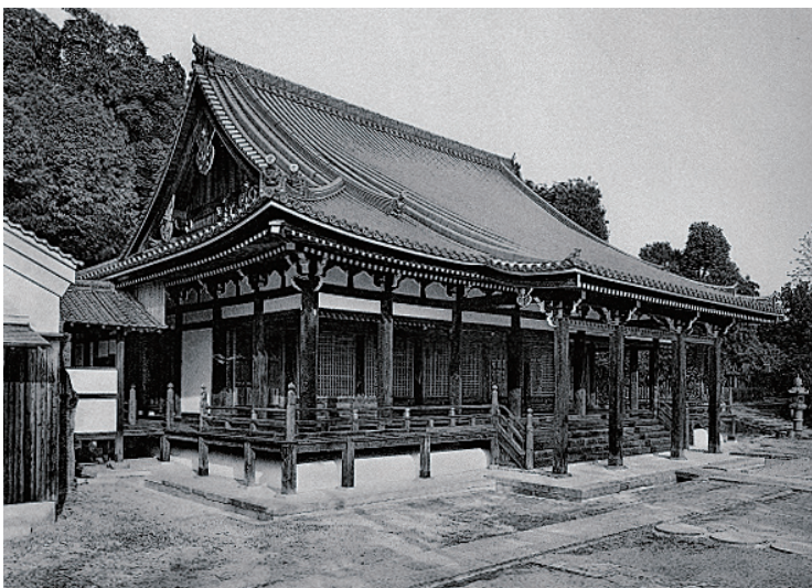
写真1 重要文化財「宝塔寺本堂」修理後の南東外観
