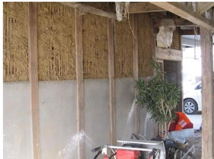
土塗り壁は、塗り土だけの仕上げの場合、浸水により土が流れ落ちている下部モルタル仕上げは脱落はない
