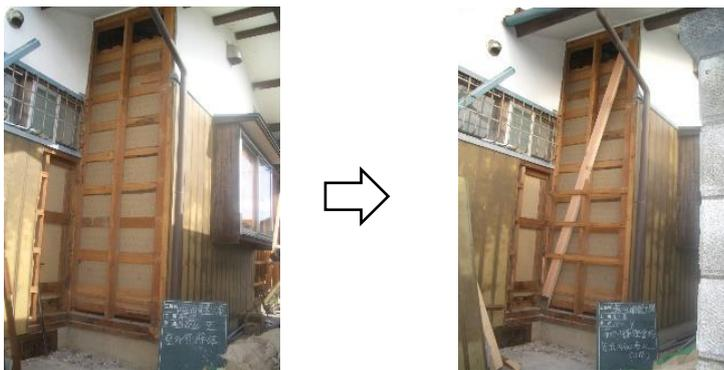
浸水被害で壁仕上げ材を撤去した場合に、復旧時に耐震性を向上させることも検討（写真は、復旧時に筋交いを入れることを想定したもの）
