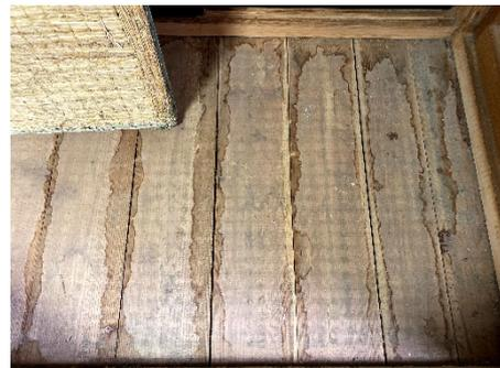
浸水後床下乾燥が不十分のため、床板が湿り、畳の含水率は32%
