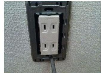
コンセントプレートをはずすと仕上げ材料の湿り具合などがわかる。
