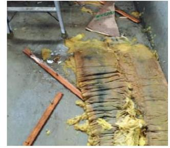
グラスウール系の断熱材は乾燥しない。毛管現象で水位以上に浸透している。また、グラスウール等の断熱材は、下部に水を含んで重くなり、壁内部の下にずれ下がってしまう。
