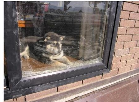
アルミサッシの枠は損傷していないが、ガラスは水流によって流れてきた物の衝撃で割れてしまうことがある。
