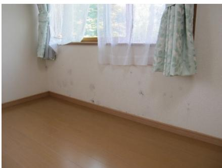
内部断熱材（グラスウール）を撤去せず
