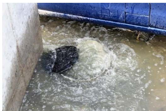
下水道処理場の冠水によりマンホールから汚水噴出（日本経済新聞から）
