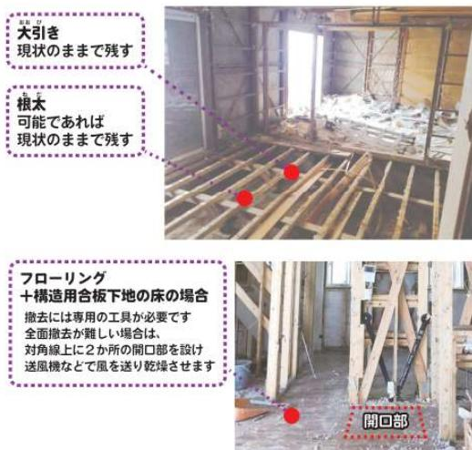
※床板の撤去後は汚泥の除去洗浄・乾燥・消毒を行う
