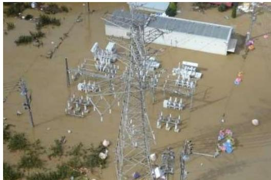
冠水した送電設備（長野市豊野町：中部電力の情報から）
