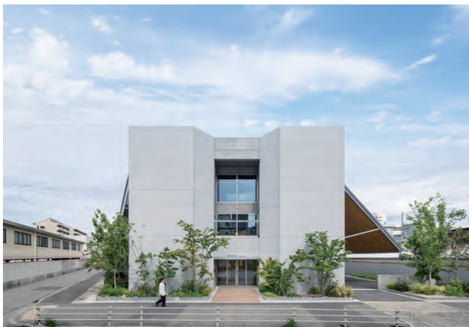
既存建物から北側と南側に木と鉄骨を使って増築した大庇が跳ね出す（写真：ナカサ&amp;パートナーズ）
