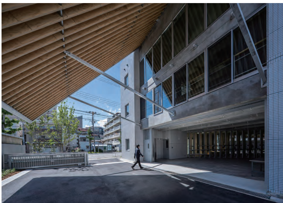
南側大庇 2階事務所を直接日光と近隣からの視線から守りつつ、荷捌きスペースとつないでいる (写真:母倉知樹)
