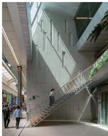
2階への階段、アーケードの上下空間を望むテラススペース、3階にガラススクリーンを設けて動線と視線を繋ぎ、建物とアーケードの繋がりを立体的に拡張した
