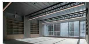
左上) ラチス梁、フェローデッキ、打込型枠の木毛セメント板など、施工時の設えをそのまま表した事務室空間 右上) ラチス梁は照明下地を兼用、ダクトレス空調と合わせて設備機器を排したノイズレスな天井面を実現 右下) ノイズレスな天井面とライトシェルフにより自然光を室内へ引き込む
