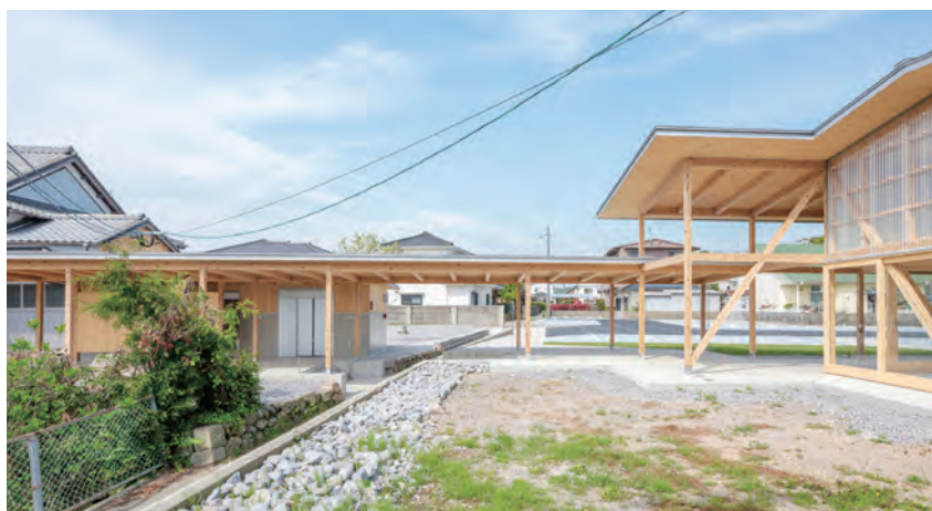
古民家改修のテレワーク棟とチャレンジショップ棟の間にある里道をまたぎ連続する屋根が全体を繋ぐ
