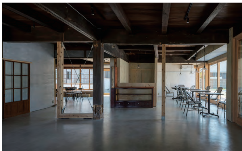
1階カフェ・展示スペース 床組みを撤去、コンクリート土間が構造補強を兼ねる
