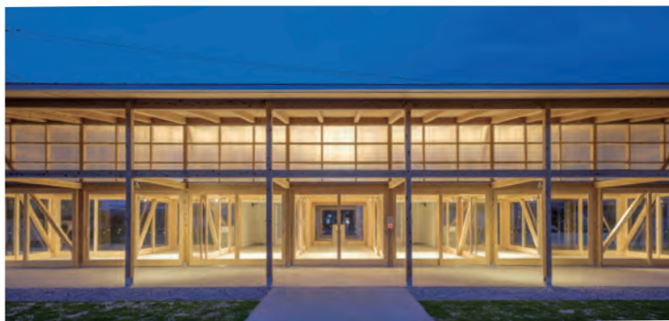
夕景 ガラスと欄間に設けたFRP板を通して室内が浮かび上がる
