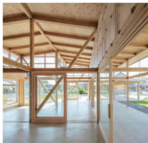
チャレンジショップ棟内観 同サイズのスギ材で軽やかに組み立てられた木造の空間は恒久的でありながら仮設的な付まいで、活発な地域の交流拠点となっている
