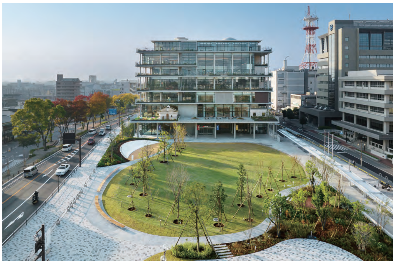
北側からの鳥瞰全景
