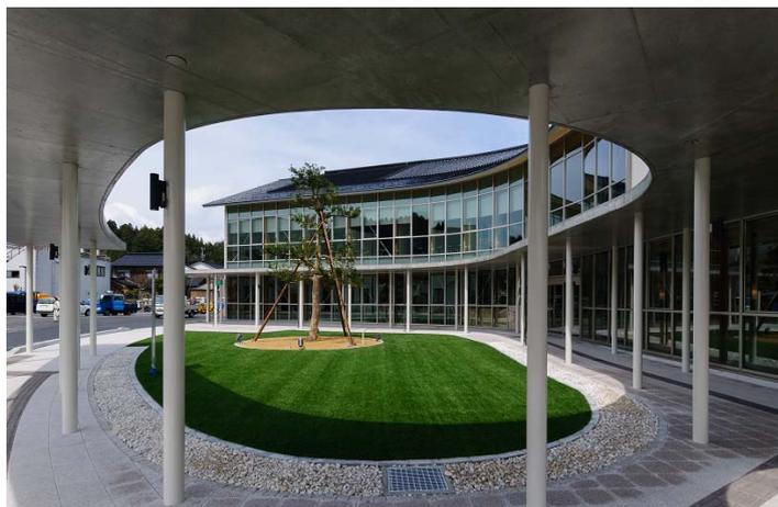
宇出津駅跡地に計画した施設は、社会教育、観光情報発信、交通拠点としての機能を持ち、柱に能登ヒバ集成材を使用した大規模木造建築である。宇出津港の馬蹄型の湾をモチーフとして、キャンピィで囲い込むようにしている。地中熱を利用した換気システム（クール&ヒートトレンチ）を導入、環境と省エネに配慮している。
