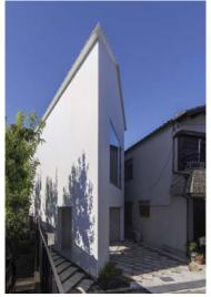
堺市の住宅地に建つ個人住宅である。2つの行止り=ドンツキに挟まれた閉塞的な空気感を流すように妻面を傾け、内部に平行四辺形の空間を設けた。このことで対面する建築とは十分な距離感を生み、内部は発見的に空間の拡がりを感じる。
