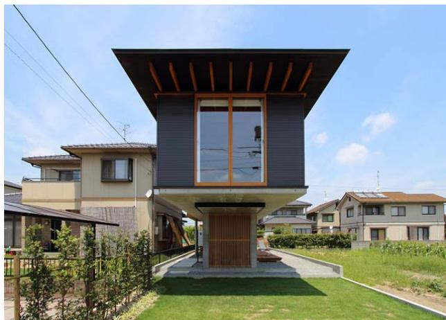
敷地は軟弱地盤な上、大雨により浸水2mが警戒される地域に属す。浸水被害や地盤補強範囲の検討から、1階をRC造で極力小さく造り2階に軽く木造を載せた住居がこの地に相応しいと考えた。RC造ならではの1階の深い軒下空間は様々な可能性を秘め2階の木造空間ともども構造と意匠が一体となったお互い相性の良い混構造の建築が出来た。
