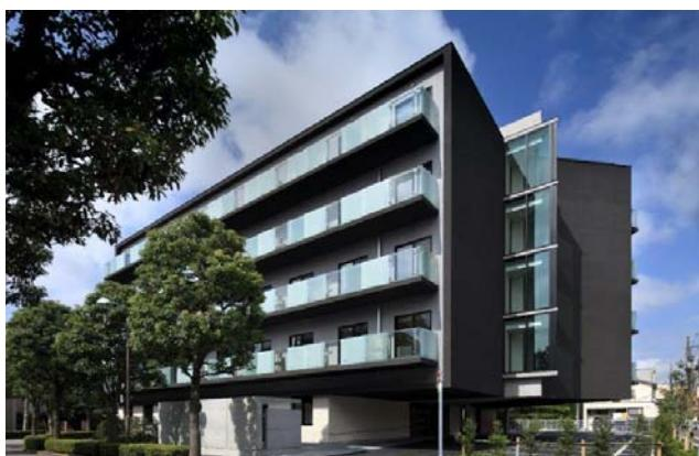
三角形独自の視覚効果を3次元的に繋げることで、矩形平面にはない新たな空間の圧縮と膨張を感じられる。吹抜けは、まるで万華鏡のような幻想的で絵画を思わせる空間が表出している。構造的にもExp.Jと柱のない基準階、PCとフィーレンデール構造の融合による12mの4層キャントリーベーは類を見ない高い技術を示している。
