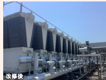
空冷モジュールチラー(高COPタイプ・電気熱源)
