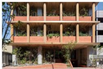
建設残土を用いた土壁や吉野杉などの自然素材を用いたエントラン
