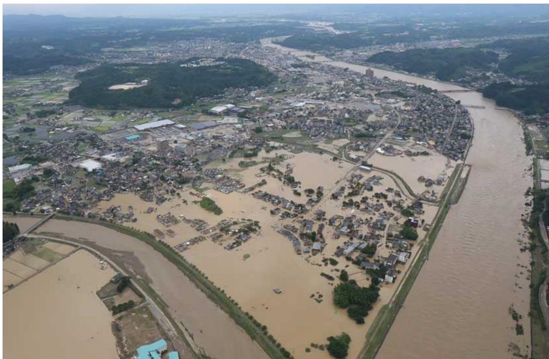
豪雨により球磨川が氾濫し浸水した熊本県人吉市街
