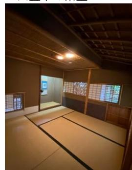
大広間のRC造の壁の厚みによって生まれた空間は広縁や廊下との緩衝スペースとしてデザインされている。また間接照明の柔らかな明るさで大広間だけでなく、庇や庭までを全体の空間に包み込む温かみを感じさせてくれる。そして鴨居の吊り束には両面木目が美しく出るよう浮彫ではなく彫り込みで装飾が施されている。ひとつひとつ手作業で丁寧に造られており目を引く美しさである。二階の6畳の和室からは季節を感じられる美しい庭園を望むことが出来る。
