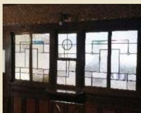
ゲストルームは、木造2階建の洋風建築。外壁はモルタルスタッコ塗りの壁にステンドグラスをはめ込んだ窓、装飾金物のついた暖炉用煙突及び軒先・けらばには装飾を施したブロンズのカバーモールを使用している。内部は、漆喰レリーフ格天井や大理石製のマンテルピース、幾何学的な分割が見られるアールデコ調のステンドグラスなど、色彩豊かにコーディネートされた特注の内装材が数多く使用され、贅を尽くした内容となっている。
