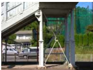
大田市駅跨線橋
