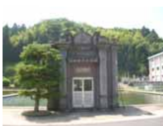
松江の忌部浄水場貯水池
