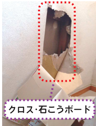
断熱材(グラスウール) 浸水部分はすべて撤去
