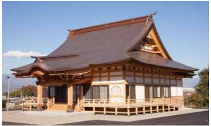
諏訪に古くから伝わる社寺建築の技法である大隅流の木割と木組を用いた伝統工法を用いた設計とし、同流派の宮大工として実務を行った経験を生かし古来の工法で施工出来るように設計監理をした。
