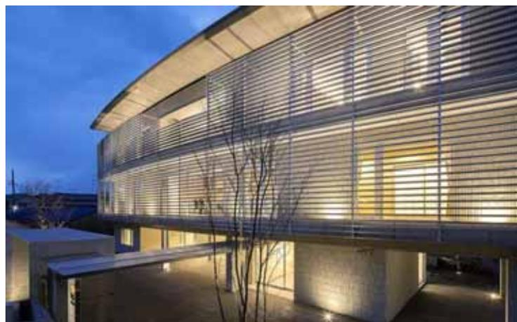
所蔵する絵画や彫刻などを、住まいながらゆつたり鑑賞できる家。季節毎の直射日光制御とプライバシー制御を兼ね、南面および東西面にアルミ製ルーバーを設置。ゼロエネルギー住宅を目指し、屋上全面にソーラーパネルを設置。大地震による影響を極力軽減し、震災時の地域防災拠点とすべく、液状化を考慮した杭工法を選定。
