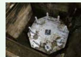
円柱及びCLT耐力壁の主要構造躯体は小径の鋼管杭に直接緊結して支持することで、位置やレベルの調整が容易となる。それ以外の構造体は後打ちの土間コンクリートで支持する。上部構造の解体後は土間コンクリートは破碎し、鋼管杭は逆回転で引抜き、元通りの敷地に戻すことが可能である。
