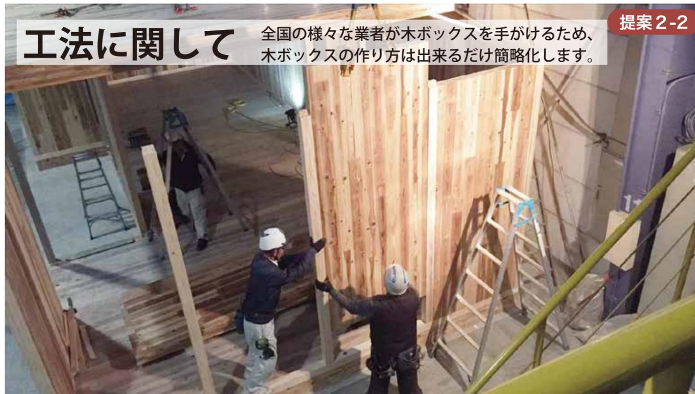
基本的にはボックスの四隅に柱を建て、柱の間に木パネルを落とし込む工法計画とします。この工法システムを採用することにより、一般的な木造住宅の構造用金物を使用する事が出来ます。木パネルはCLTや合板など、各地域にあった工法で作られます。
