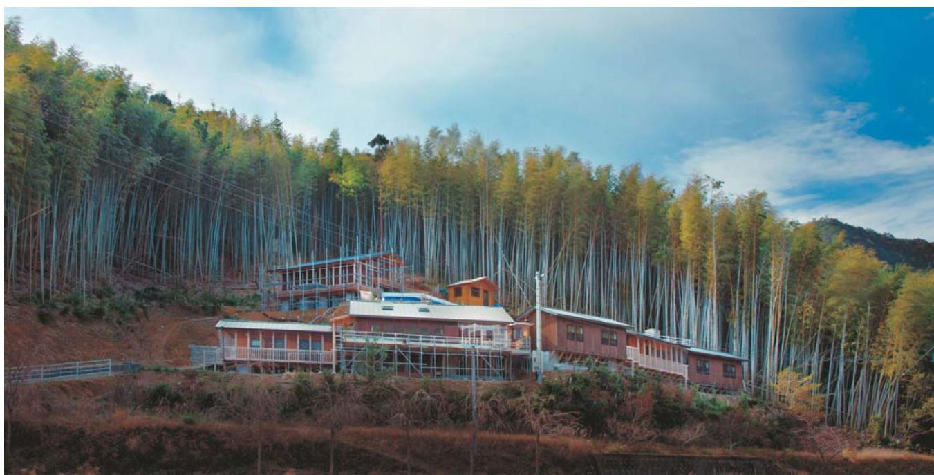
写真4 蘭から「こうのすまい」を望む。連なる方杖による新しい集落の風景。分棟にして道路の湾曲に沿わせている。建物の幅を小さく、基礎はさらに小さく
