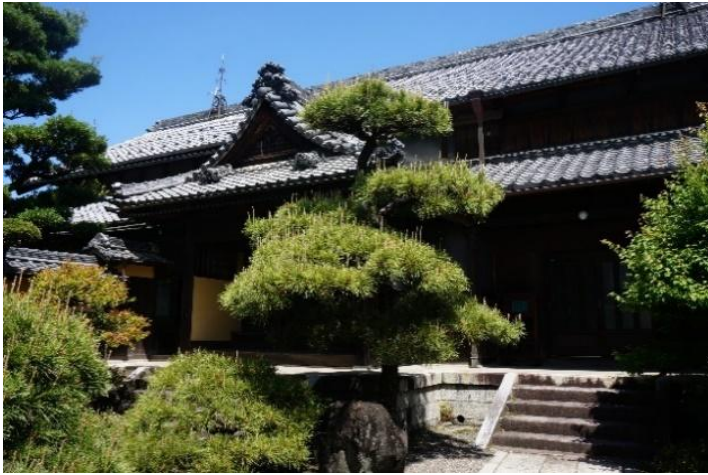
外観：式台玄関付近
