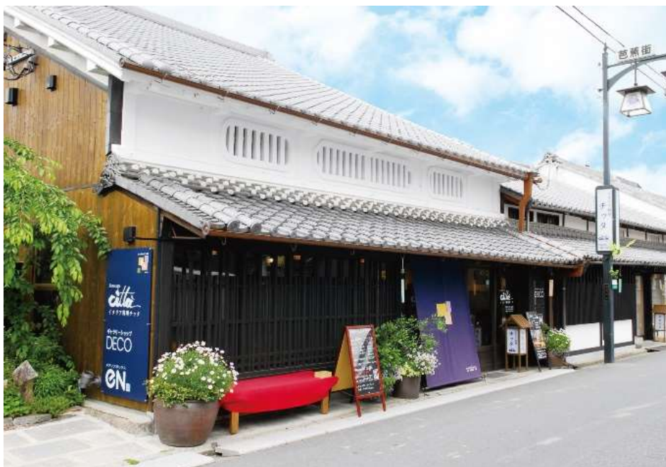
▲大和街道に面し「虫籠窓」「子持格子」など当時の面影を残す外観
