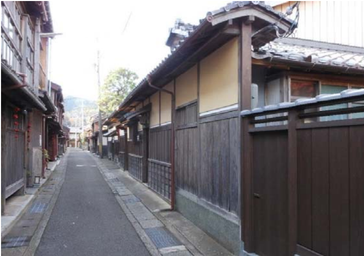
外観正面（三丁町通り北から）
