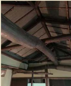
内部の迫力ある曲がり梁
