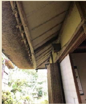
貫通した曲がり梁
