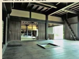
居間には養蚕用の小屋裏へ上る階段がある。
