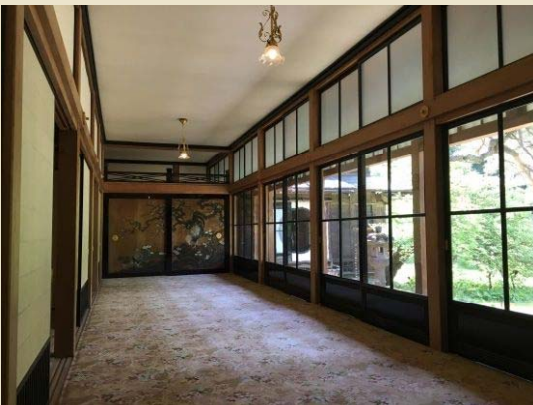
御座所入側：鳥の子紙の張付壁と張付天井、杉戸絵、黒漆塗りの硝子戸、そして畳敷きの上に英国製の絨毯を敷いた和洋折衷様式。
