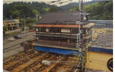
写真③ 工事中の曳家の様子
