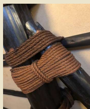
伝統的な叉首組構造部分
