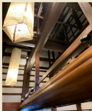
圧倒される土間空間の豪壮な梁組と吹抜
