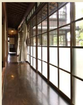
長さ6間半、幅3尺、厚さ1寸のけやきの一枚板を使用した1階廊下
