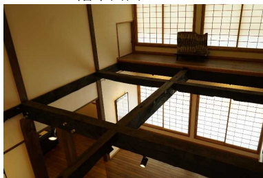
2階 梁組が現しとなった吹抜け
