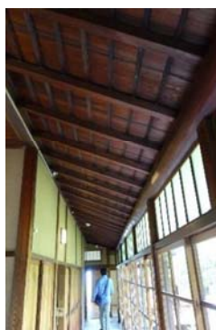
飴色に光る長い丸桁が建物外周を囲み、大工の技量の高さが伺える
