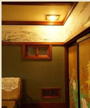
換気対策小窓
