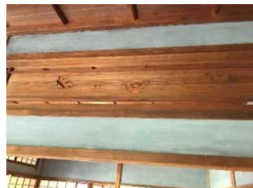
使用者の間棟の欄間：中国故事の縁起をかついで蝙蝠の型で抜いてある
