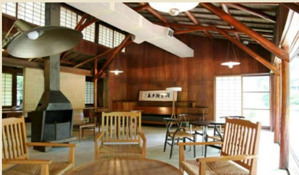
居間には暖炉があり、ノエミ夫人のデザインによる家具が置かれている。壁はラワン・ロータリーベニヤ貼。北側には障子のトップサイドライトを設置。天井部分中央のダクトはセントラルヒーティング。
