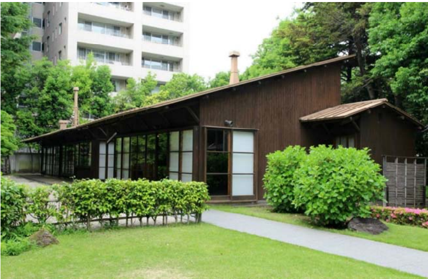
南側外観。杉材縦板張りの外壁、日差しや雨を調整しつつ建物に奥行きを与える深い軒が印象的。雨樋は無い。
