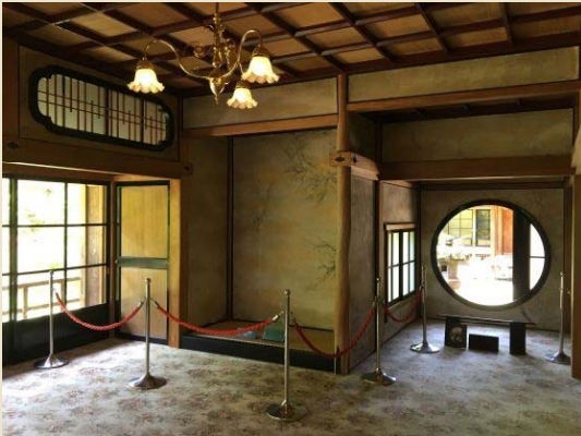
御学問所（梅の間）：書院風の角長押が数寄屋風の丸太の床柱に巻き付いた混在の造りになっている。
