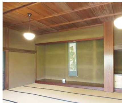
床の間：床板は檜の一枚板、床柱は1階から通しの檜の大黒柱
