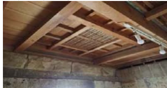
大谷石造の地下室の通気口
