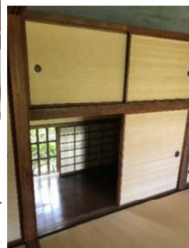
使用者の間棟の押入：下段は貴重なケヤキの一枚板。明り取りの工夫もされている
