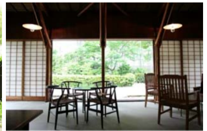
三方を「芯外し」の連窓とした居間南側。建具を解放することで庭園と居間が一体となる。網戸は無い。深い軒が落ち着いた室内空間をつくっている。
