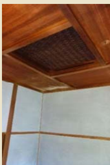
湯殿棟の網代天井：湯気の逃げ道にもなっている。邸宅内で一番凝った天井かもしれない
