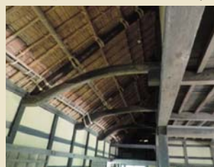
土間北側の小屋裏
