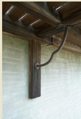
濡れ縁を支えている持送り
