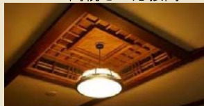
照明器具周りの排気口
