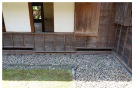
湿気の溜まる北側の床下に通気口。寝室の畳下地は通常より厚い24mm。東日本大震災でも目立つ被害はなかった。
