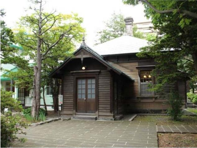
旧永山武四郎邸は、第二代北海道庁長官・永山武四郎が屯田事務局長時代に建てた私邸である。明治10年（1877）代前半頃の創建で木造平屋建て、建築面積136.06㎡の和洋住宅である。小屋組は、洋式のキングポスト・トラス。外壁は低い堅羽目の腰を回し、上部は隅柱型付の下見板張りとしている。玄関棟の妻に十字型の飾りがついている。
